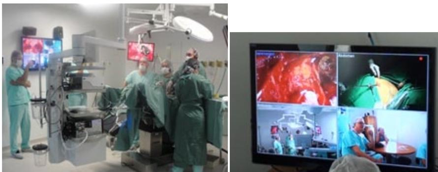
Fig. 2. Sala desenvolvida pelo grupo no âmbito de um edital FINEP, com parceria da Santa Casa de Misericórdia de Porto Alegre (ISCOMPA). O grupo desenvolveu a sala cirúrgica completa, desde apoio ao desenvolvimento das estativas (pendentes do teto), até a integração com videolaparoscópios. O foco do projeto, entretanto, foi no software de videoconferência.
