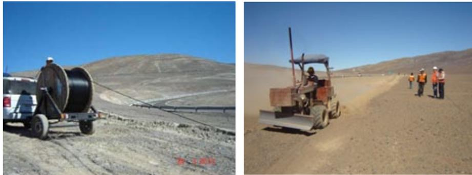
Figura 3 (Izquierda) el cable se instala directamente en la zanja abierta (derecha) una máquina rellena la excavación, luego se compacta
