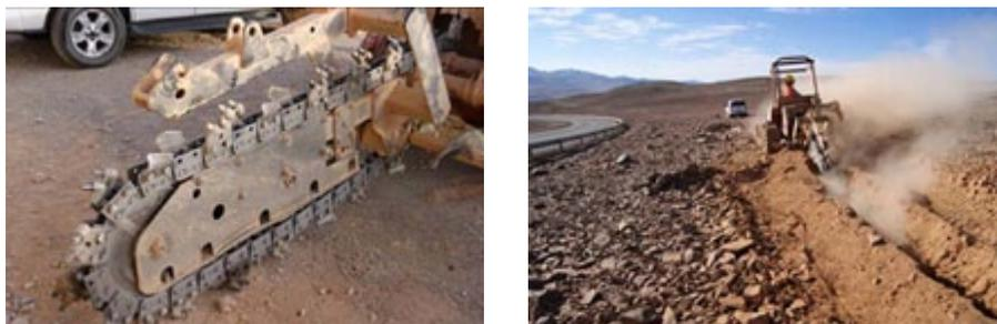
Figura 2: (Izquierda) herramienta que se utilizó para hacer la zanja donde se deposita el cable (derecha) excavación.
