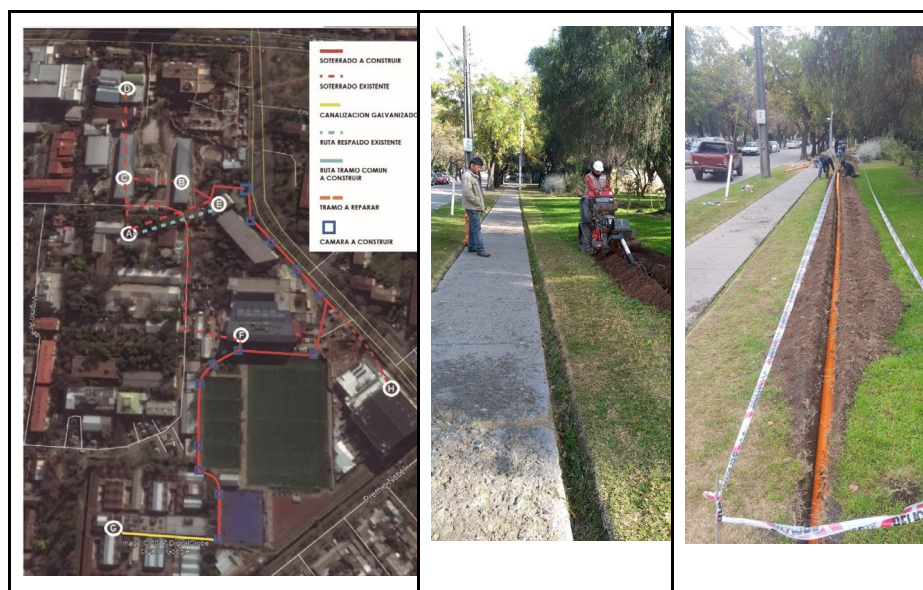
Figura 5. Tramos a construir en campus Juan Gómez Millas. Máquina zanjadora y canalización final.
